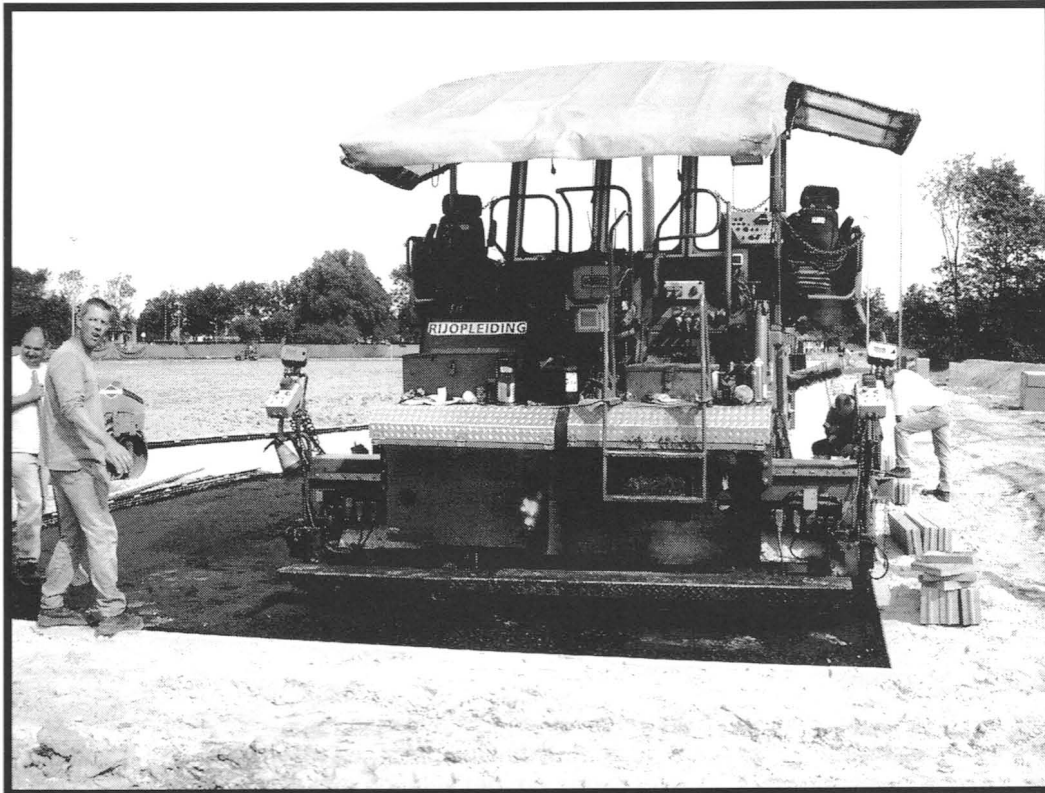
Asfaltmachine is bezig met asfaltlaag aanbrenen op het schuimbeton.
